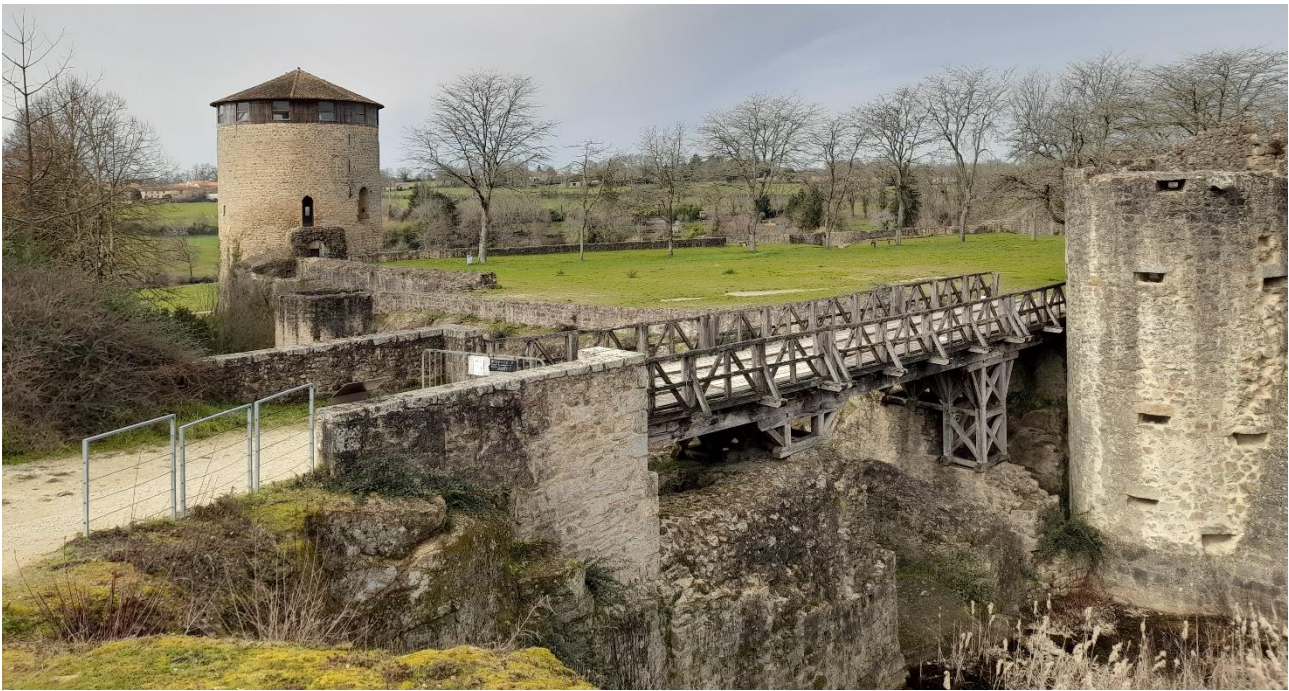
Passerelle du château de Parthenay (Source : CC Parthenay-Gâtine)
